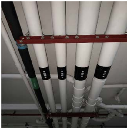
รูปที่ 2-26 ระบบระบายน้ำในโครงการแบบแยกท่อ
